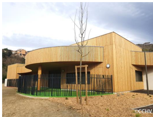
Nouvelle crèche intercommunale d'Amélie-les-Bains
