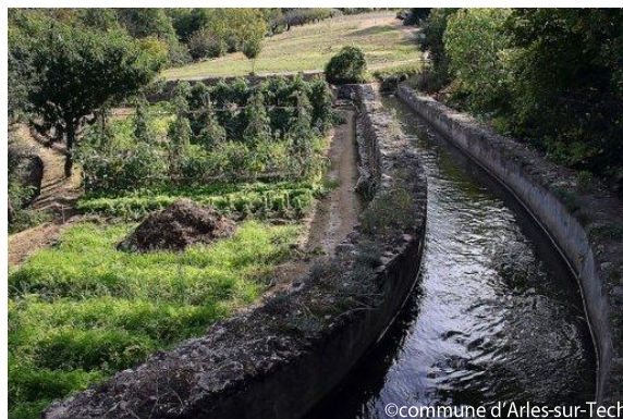
Canal du Pont Neuf à Arles-sur-Tech.
