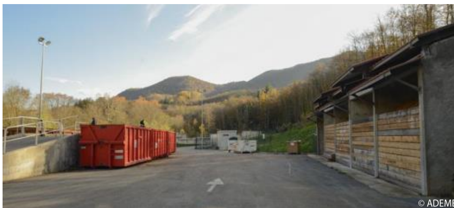
Saint-Laurent-de-Cerdans : le hangar de stockage des plaquettes forestières, implanté sur la déchèterie communale.
